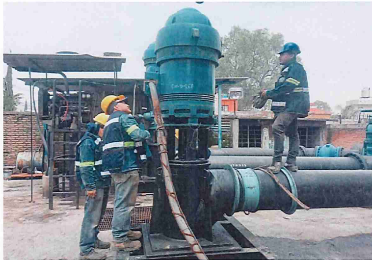
Montaje de bomba en Cárcamo, Cuautitlán
