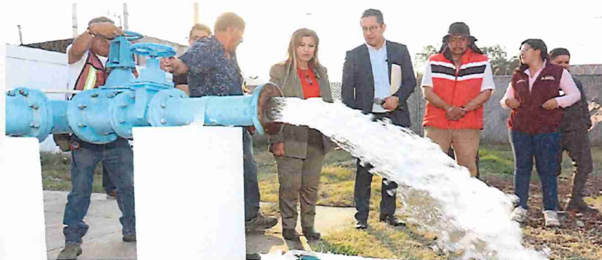
Rehabilitación de Pozo de Joyas, Cuautitlán
