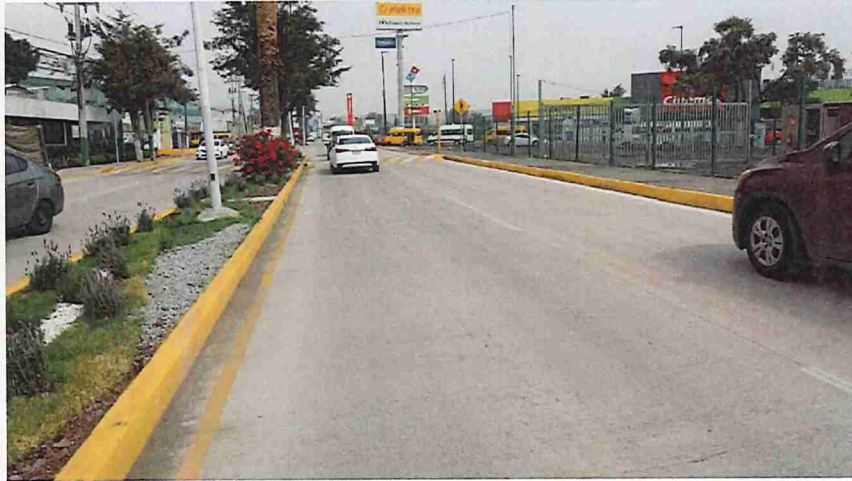
Reconstrucción con concreto hidráulico de la avenida Universidad.
