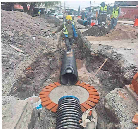
Construcción de drenaje en Xalptipa, Cuautitlán
