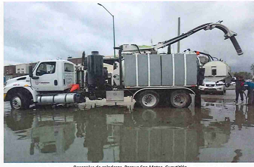
Desazolve de coladeras, Parque San Mateo, Cuautitlán
