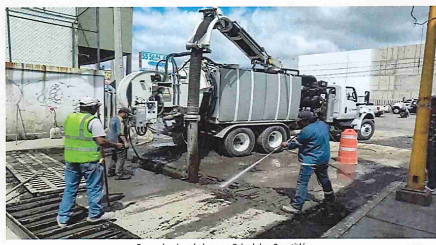
Desazolve de coladeras en Cebadales, Cuautitlán
