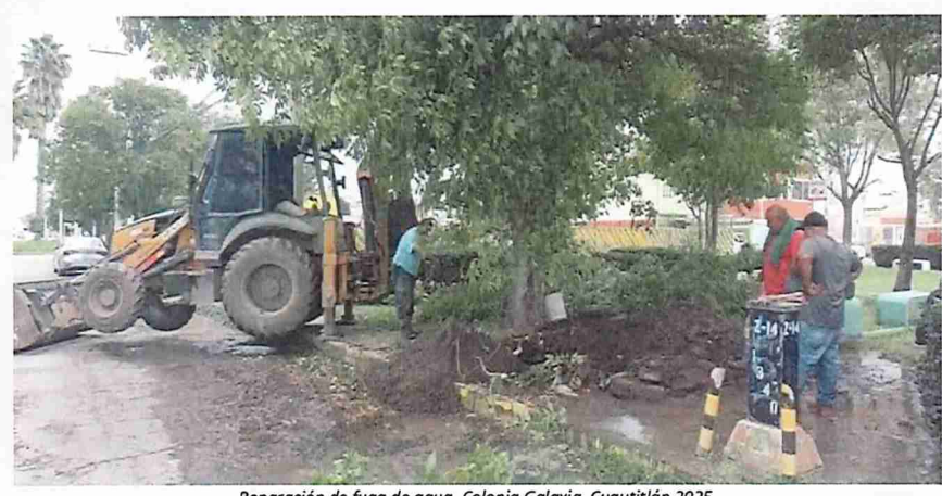
Reparación de fuga de agua, Colonia Galaxia, Cuautitlán 2025.
