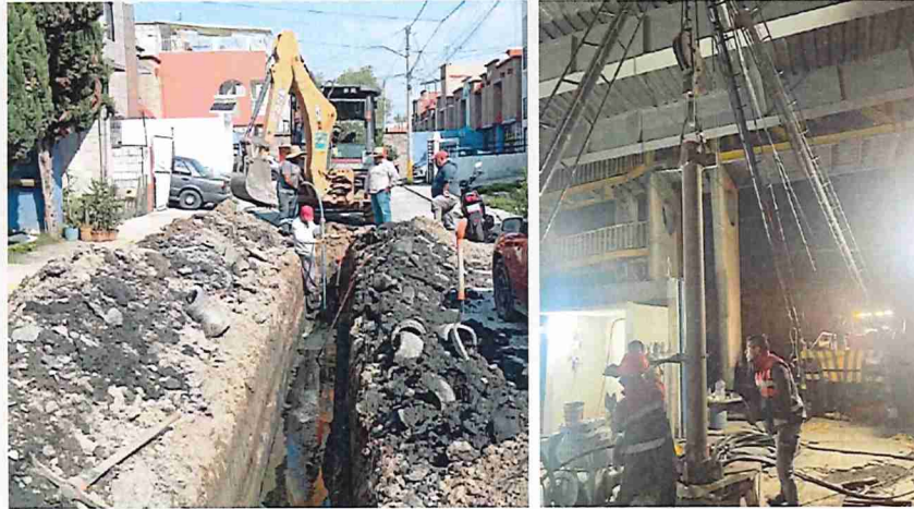
Sondeo de tubos y pozo de visita para la reparación de la línea general en la calle Mar de Filipinas, colonia Joyas de Cuautitlán y instalación de la columna con el tubo No. 31 de 3.0 m por 8" de diámetro en el Pozo Española.
