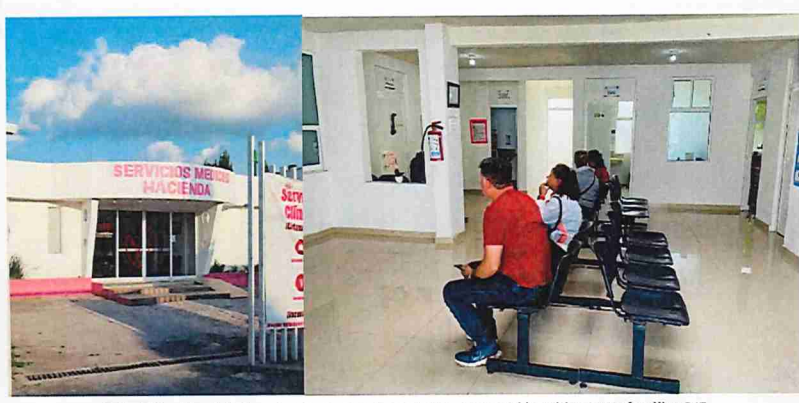
Rehabilitación de infraestructura para la atención, prevención y bienestar familiar DIF
