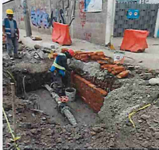
Inspección de obra Avenida Universidad
