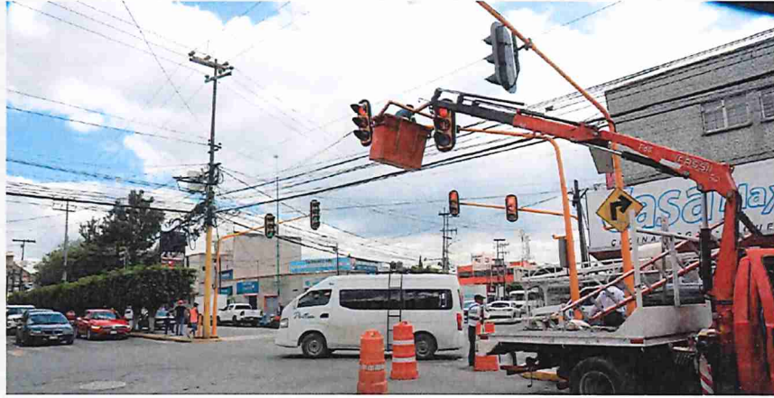
Mantenimiento a semáforo por parte de Ingeniería Vial y Semaforización de la Guardia Civil en avenida 20 de Noviembre
