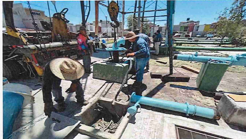
Mantenimiento del pozo Galaxia, Cuautitlán
