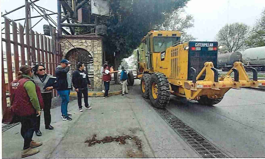
Gestión de motoconformadora para la rehabilitación de caminos saca cosecha en Cuautitlán
