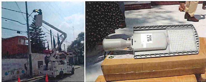
mantenimiento del alumbrado en la colonia Santa María Huecatitla
