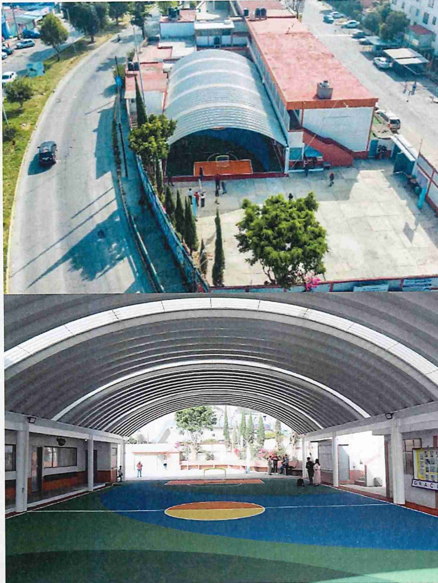
Construcción de arco techos y rehabilitación de espacios en escuelas de educación básica
