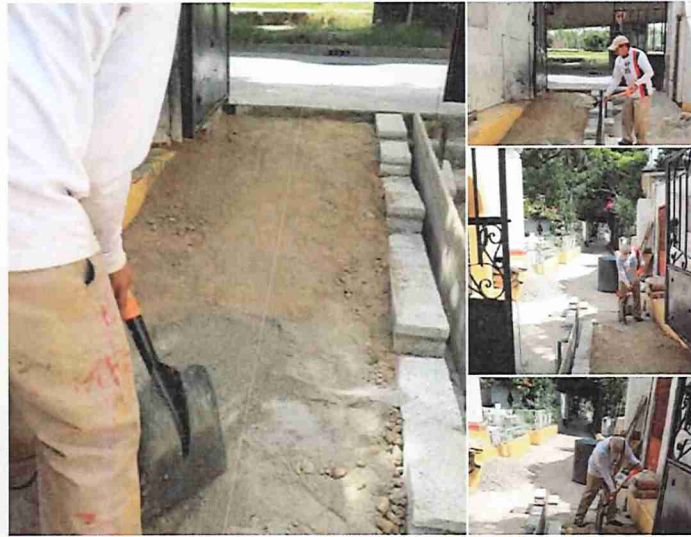
habilitación de una rampa múltiple en el Panteón San José Milla
