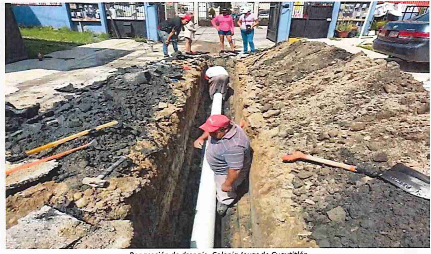
Reparación de drenaje, Colonia Joyas de Cuautitlán
