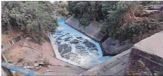
Ilustración 27. Canal de aguas negras.
