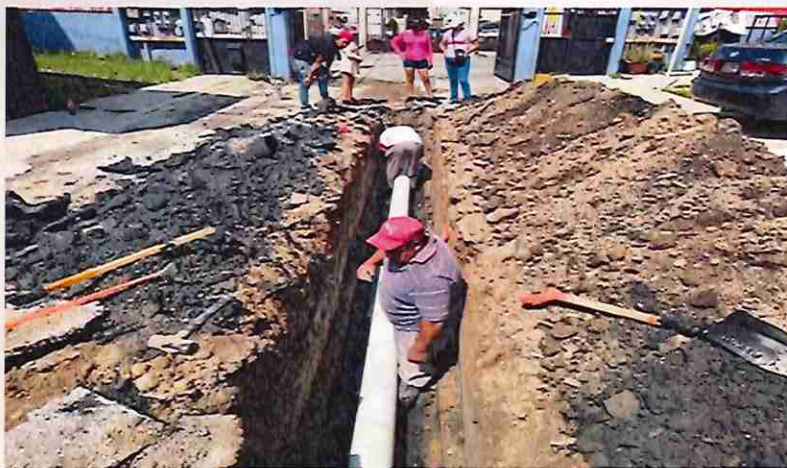
Reparación de drenaje, Colonia Joyas de Cuautitlán
