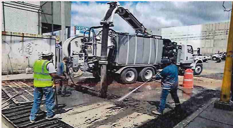
Desazolve de coladeras en Cebadales, Cuautitlán
