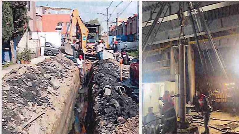
Sondeo de tubos y pozo de visita para la reparación de la línea general en la calle Mar de Filipinas, colonia Joyas de Cuautitlán y instalación de la columna con el tubo No. 31 de 3.0 m por 8" de diámetro en el Pozo Española.
