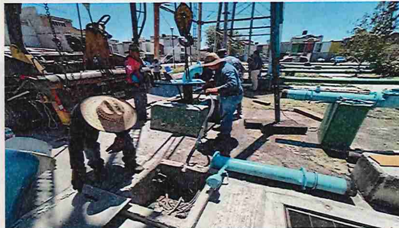
Mantenimiento del pozo Galaxia, Cuautitlán
