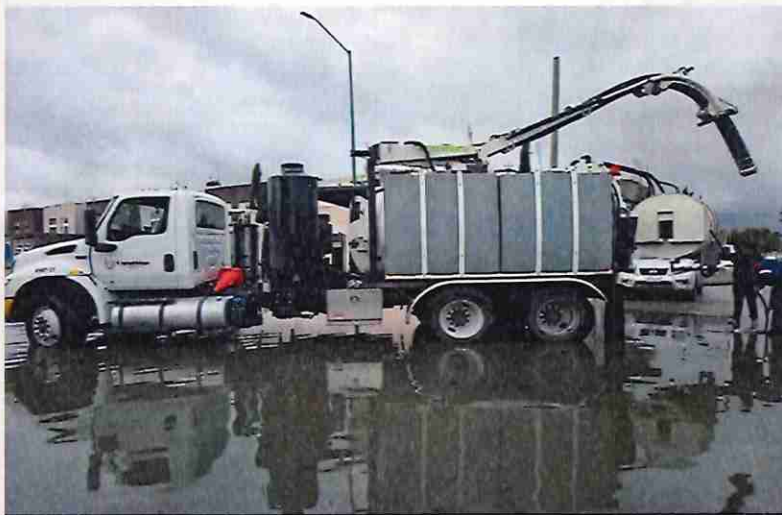
Desazolve de coladeras, Parque San Mateo, Cuautitlán
