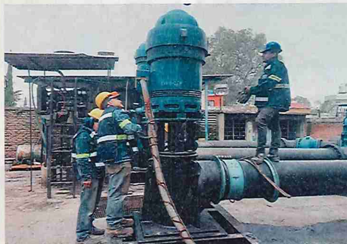
Montaje de bomba en Cárcamo, Cuautitlán
