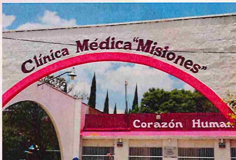
Rehabilitación de clínicas DIF
