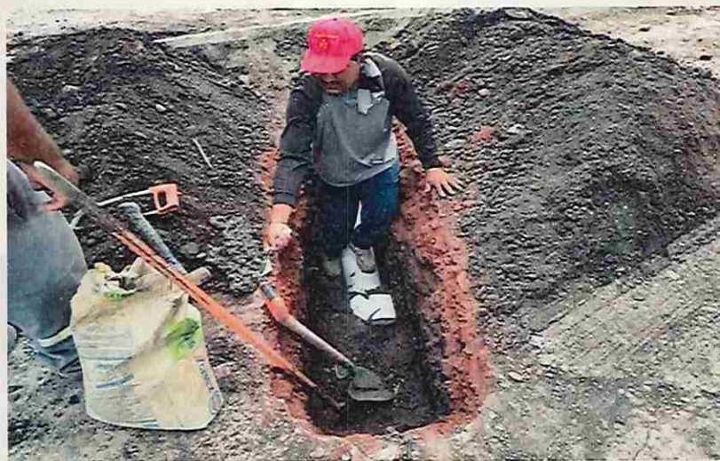
Conexión de drenaje Colonia Ejidos de San Mateo Iztacalco, Cuautitlán
