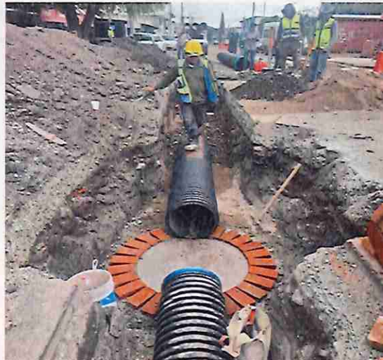
Construcción de drenaje en Xaltpa, Cuautitlán
