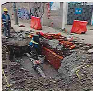
Inspección de obra Avenida Universidad
