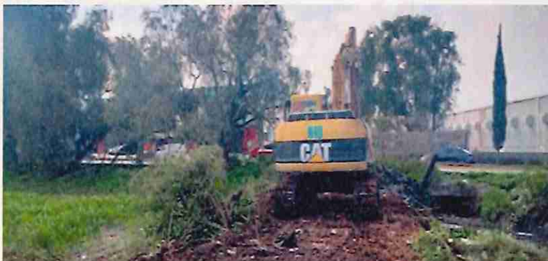
Limpieza de canales en Hacienda Cuautitlán 2025
