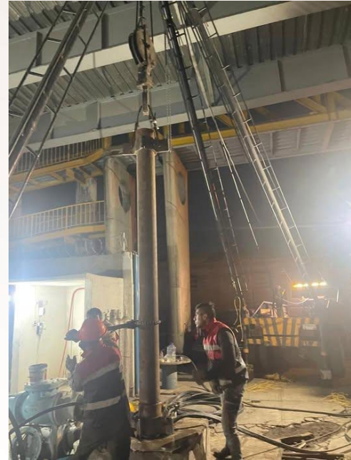
Sondeo de tubos y pozo de visita para la reparación de la línea general en la calle Mar de Filipinas, colonia Joyas de Cuautitlán y instalación de la columna con el tubo No. 31 de 3.0 m por 8" de diámetro en el Pozo Española.
