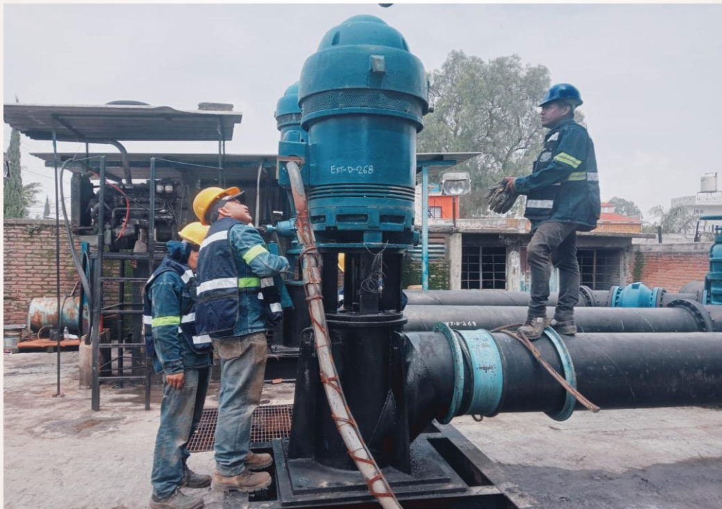
Montaje de bomba en Cárcamo, Cuautitlán
