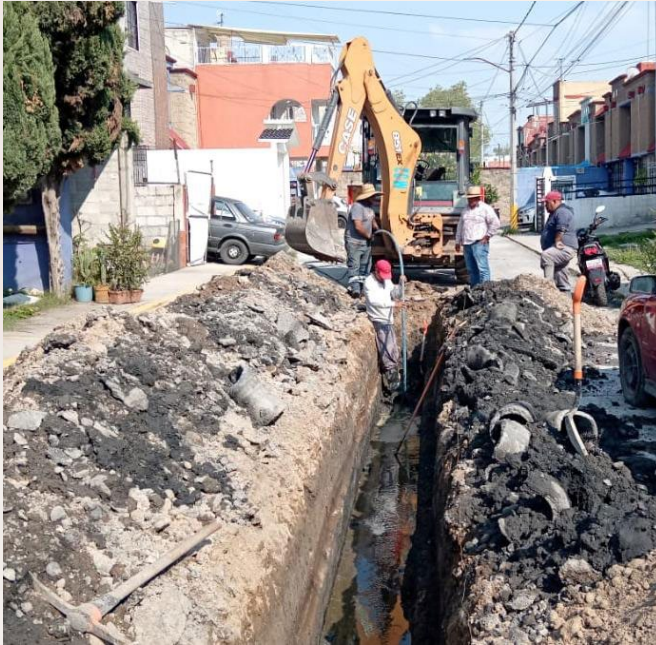
Sondeo de tubos y pozo de visita para la reparación de la línea general en la calle Mar de Filipinas, colonia Joyas de Cuautitlán y instalación de la columna con el tubo No. 31 de 3.0 m por 8" de diámetro en el Pozo Española.
